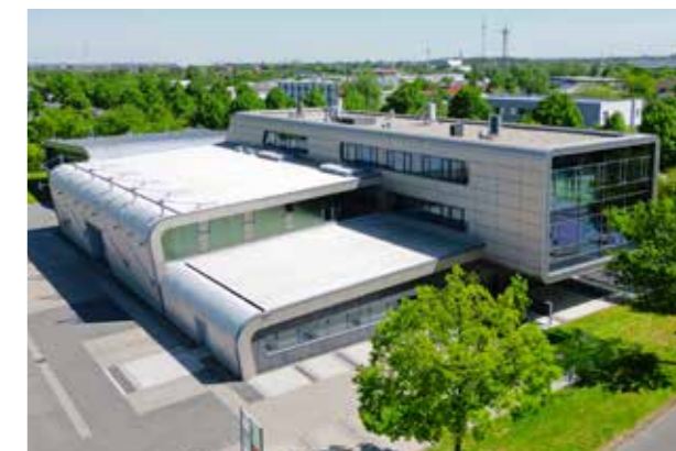
ZEE | Zentrum für Elektromobilität und Energieeffizienz © TPO
